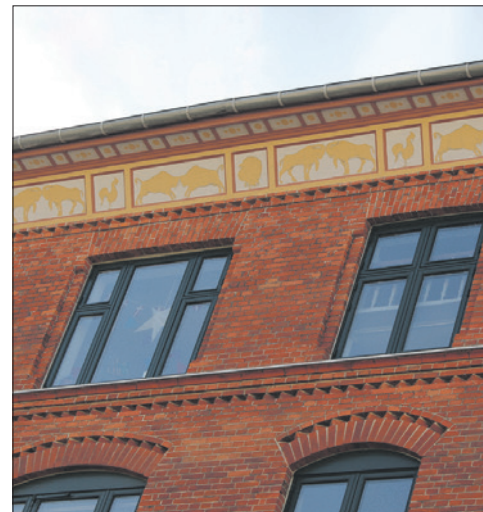
Så færdigt arbejde – helt tæt på – og ligeså flot nede fra fortovet på 20-30 meters afstand.
